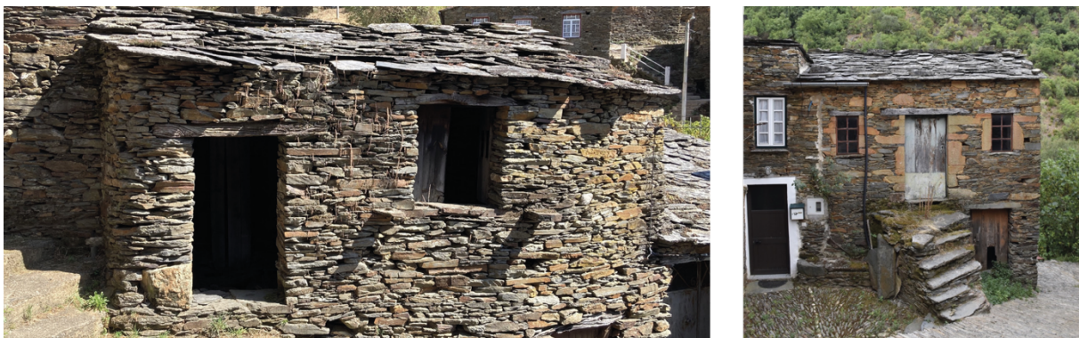
F37 (à esquerda): Casa do Tipo A em alvenaria de xisto, no Fontão.
