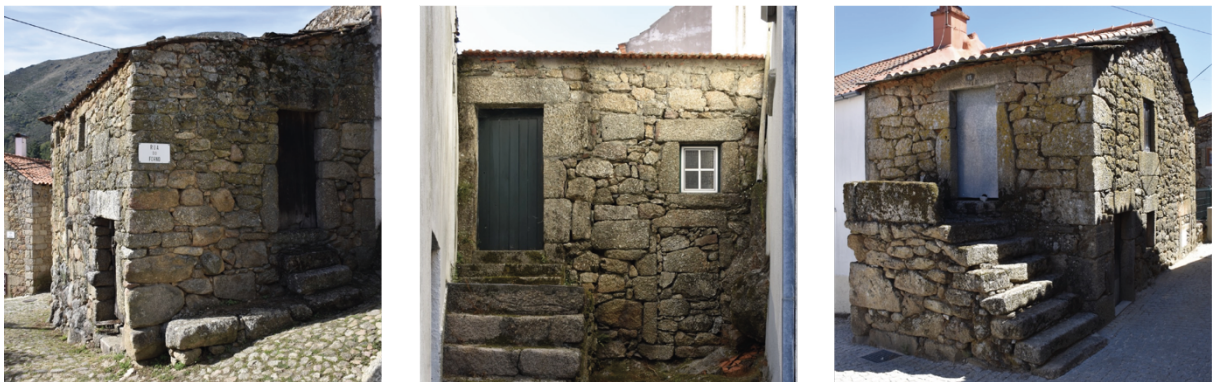
F34 (à esquerda): Casa do Tipo A em alvenaria de granito, em Vila Soeiro.
