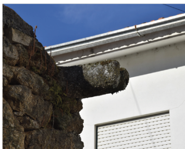
F68 (à esquerda): Goteira em granito entre duas casas em alvenaria mista de granito e xisto, em Videmonte.
