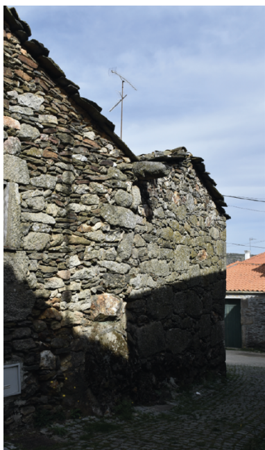
F68 (à esquerda): Goteira em granito entre duas casas em alvenaria mista de granito e xisto, em Videmonte.
