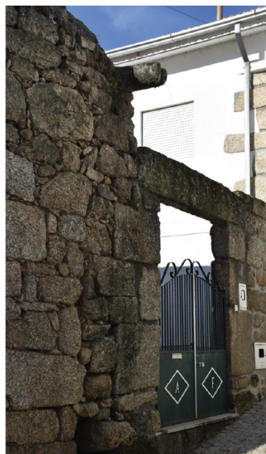
F68 (à esquerda): Goteira em granito entre duas casas em alvenaria mista de granito e xisto, em Videmonte.
